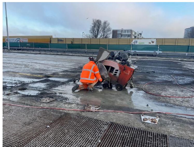
In langsricting zagen van de druklaag met cirkelzaag en lintzaag
