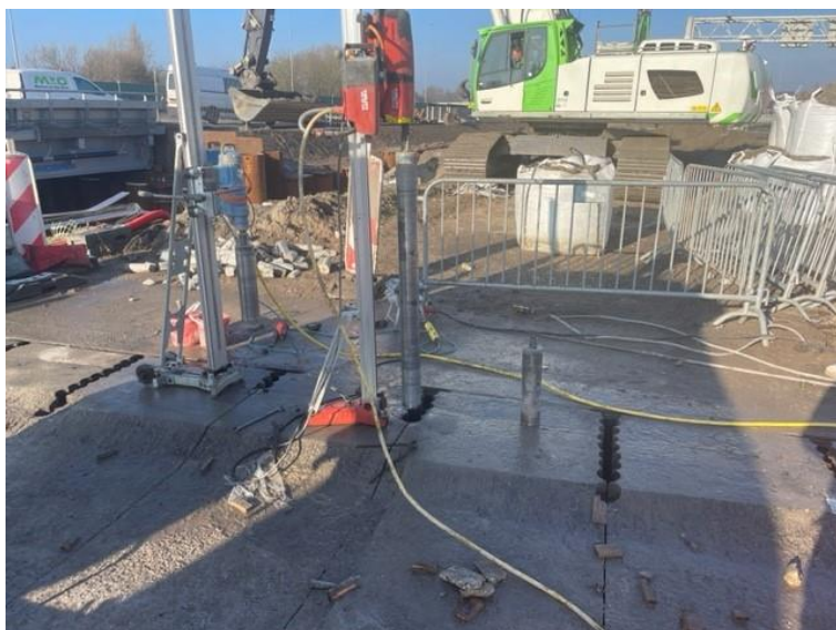
Losboren liggers van de landhoofden met appelboor
